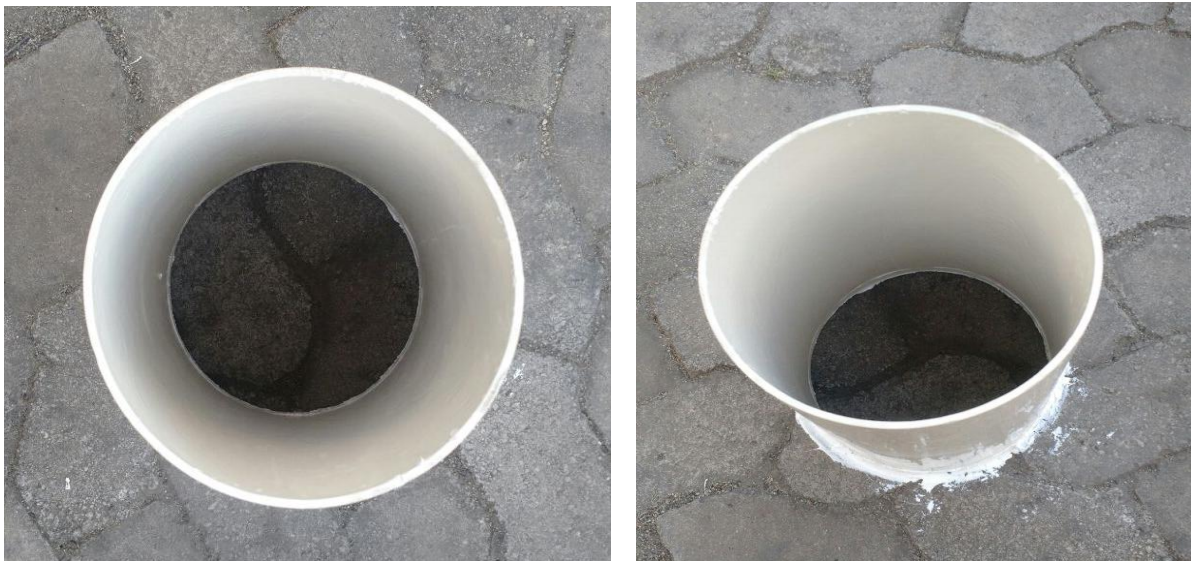
Figura 2: Cilindro instalado para o teste de infiltração Fonte: Autor (2017)
