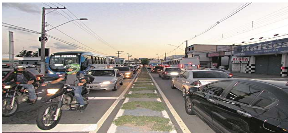
Figura 02 – Gargalo na Avenida Norte Sul entre os Terminais de Carapina e Laranjeiras
