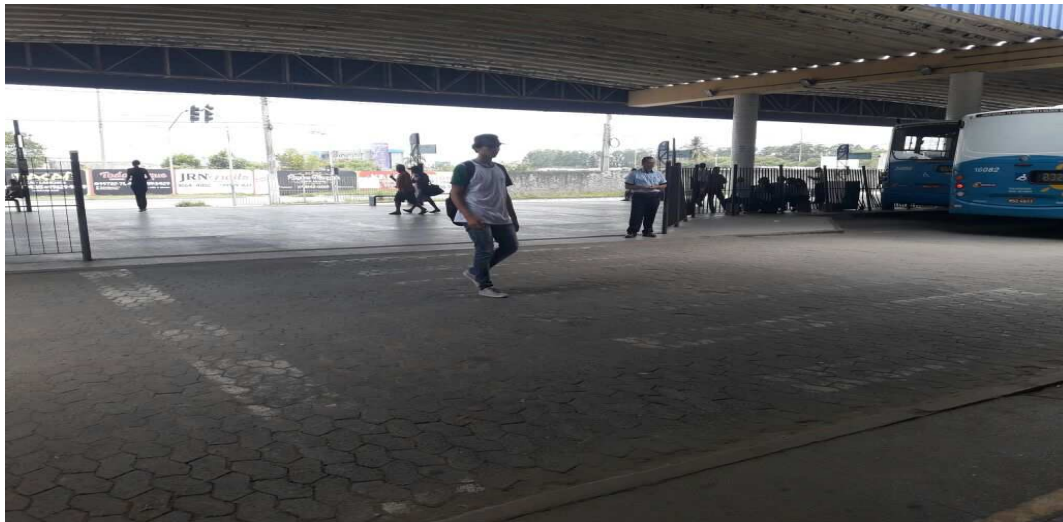
Figura 03 – Foto do Terminal de Laranjeiras com a falta de sinalização de pedestres Fonte: Própria, 2017
