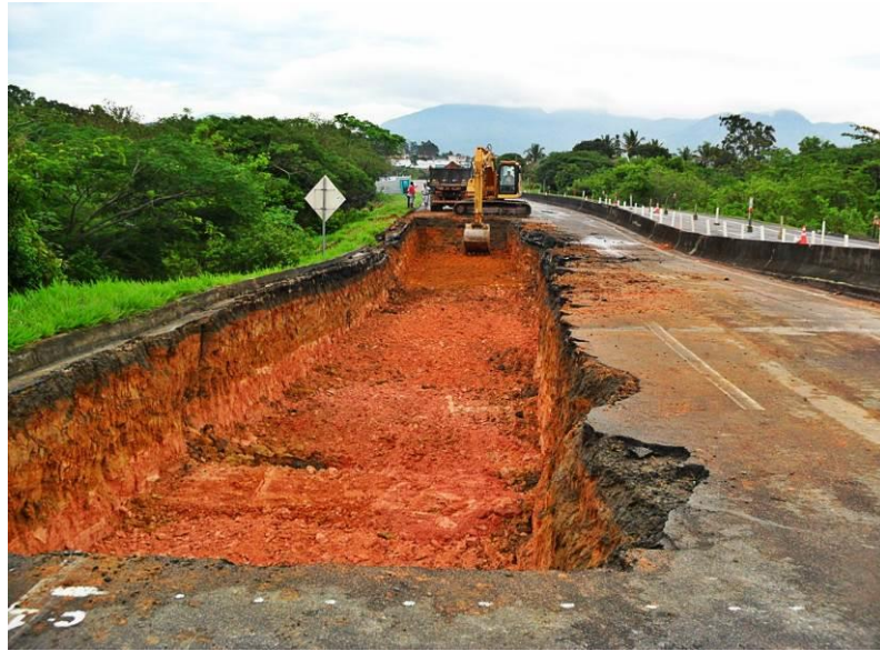
Figura 5 – Fundação de estradas Fonte: Rodosol (2013)
