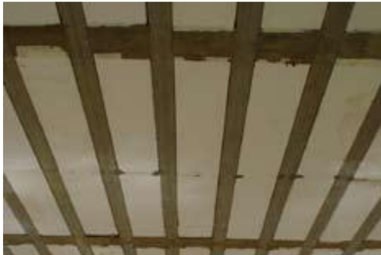
Figura 2 - Laje treliçada unidirecional com EPS Fonte: Tecnocell (2008)
