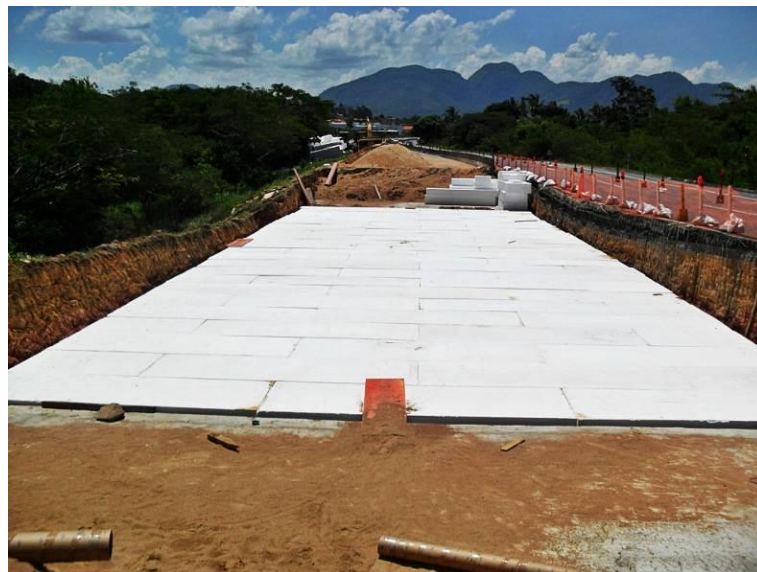
Figura 6 – Fundação de estradas Fonte: Rodosol (2013)
