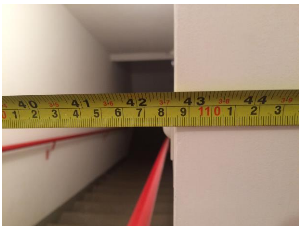
Figura 7 – Largura da escada de emergência Fonte: Autoria própria
