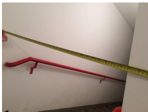
Figura 8 – Largura da escada de emergência Fonte: Autoria própria
