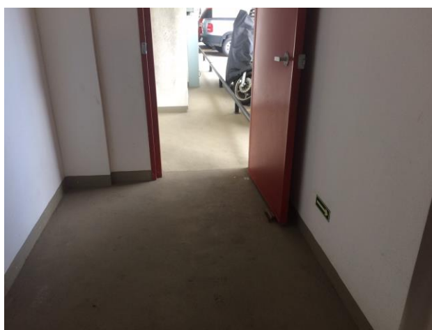
Figura 3 – Porta corta-fogo do térreo Fonte: Autoria própria
