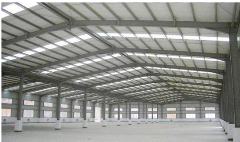
Figura 1. Galpão em estrutura de aço Fonte: www.zagoengenharia.com.br
